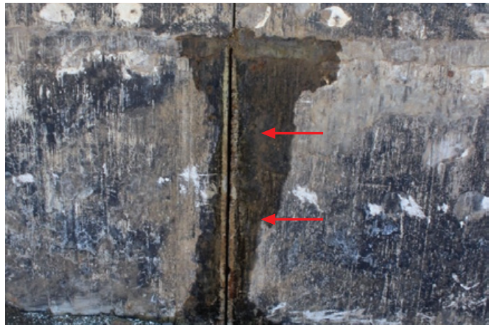
KÖSTER KB-Pur GEL ıslak derzlerin su yalıtımında kullanılır KÖSTER KB-Pur GEL is used for the waterproofing of wet joints
