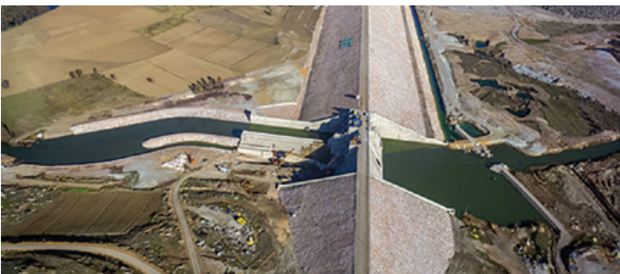
Kayseri Gümüşören HES Projesi
