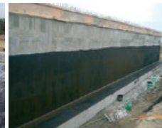
Perde duvarı yalıtımında Deuxan 2K uygulanması
