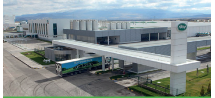
Bursa Süttaş Arıtma Tesisi
