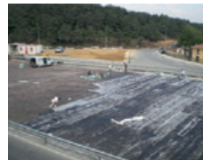
Konveyörle Deuxan 2K'nin otomatik uygulanması
