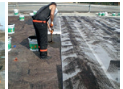
File ile birliktir Deuxan 2K uygulanması
