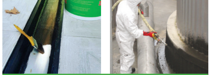
Sürülerek veya püskürtülerek uygulanabilir Brush or spray application
