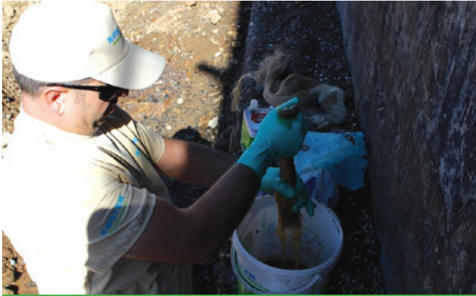
KÖSTER KB-Pur GEL hazırlanması Preperation
