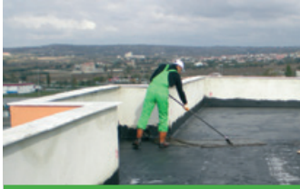
Teras Yalıtımı Terrace waterproofing
