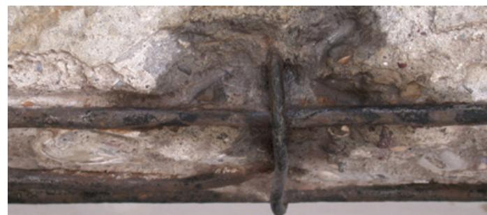
Zayıf beton ve korozyon tabakası temizlenir
