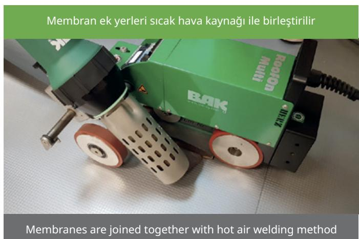
Membran ek yerleri sıcak hava kaynağı ile birleştirilir
