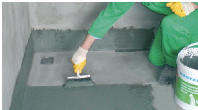
Esnek yapıdadır, ıslak hacimlerin, balkon – terasların ve depoların izolasyonunda başarıyla kullanılır. Uygulama fırça ile sürülerek veya uygun püskürme ekipmanı ile yapılır. Uygulaması yerinde yapılır, sürat ve ekonomi sağlar.
