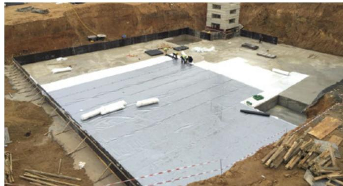
Birleştirme işleminde sıcak hava kaynak makineleri kullanılarak çok mukavemetli ve sızdırmaz ek yerleri oluşturur. İç köşe – dış köşe – su gideri ve boru geçişleri aksesuarları aynı hammaddeden üretilmiş olup, mükemmel detay çözümlerine olanak sağlar. KÖSTER ECB spesifik olarak geliştirilmiş uygulama detaylarına sahiptir. Uygulama detayları 30 yılı aşkın süredir test edilmiş ve sürekli geliştirilerek bugünkü performansına kavuşmuştur.
