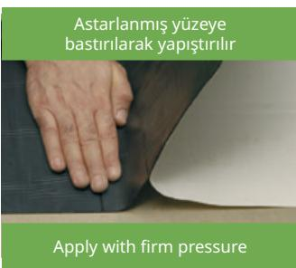
Astarlanmış yüzeye bastırılarak yapıştırılır
