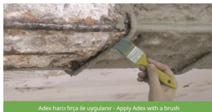
Adex harcı fırça ile uygulanır - Apply Adex with a brush
