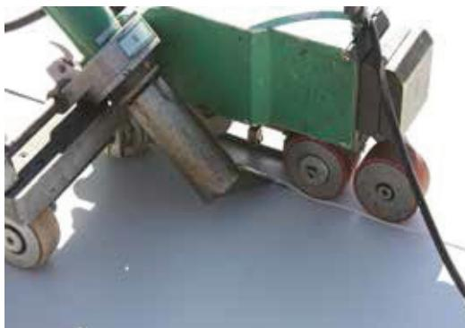
*Kaynak robottu sayesinde ısıtma ve ütüleme işlemi otomatik olarak yapılır ve sentetik örtüler kalıcı olarak birleştirilir.*
