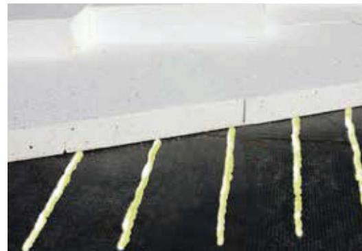
Astarlama işleminden sonra ısı yalıtım levhaları KÖSTER PUR Dachbahnenkleber ile yapıştırılmaktadır.
