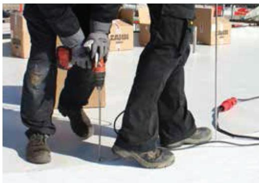
Mekanik tespit metodunda öncelikle belirli aralıklarda delikler delinir ve ısı yalıtmak katmanını geçerek sağlam çatı konstrüksiyonuna ulaşılır.
