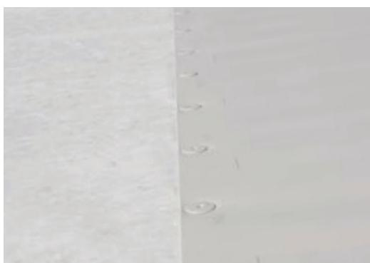
KÖSTER TPO sentetik örtüler üzerinde bini mesafeleri yeşil çizgiler halinde optik olarak belirtilmiştir. Bu sayede optimum bini miktarları kolaylıkla oluşturulmaktadır.
