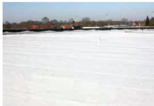
*Tüm ek ve bini noktaları kaynatıldıktan sonra balast yükleme işlemi yapılır.*
